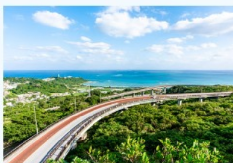
ニライ橋カナイ橋
